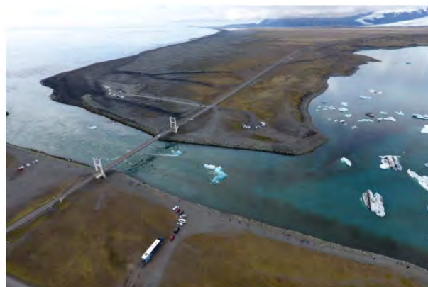
1. mynd. Jökulsá á Breiðamerkursandi og brúin yfir hana. – The glacial river Jökulsá á Breiðamerkursandi and the bridge. Ljósmynd. / Photo: Náttúrustofa Suðausturlands/Snevarr Guðmundsson, 13. júní 2018.
